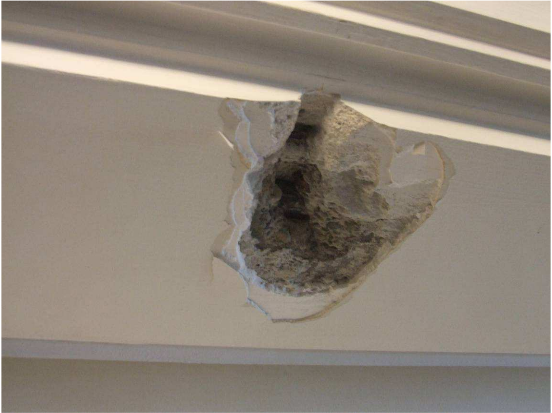
fot.6. Widok odkrywki zbrojenia dolnego w zakresie przedsionka pomiędzy magazynem ceramiki i sztuki starożytnej
