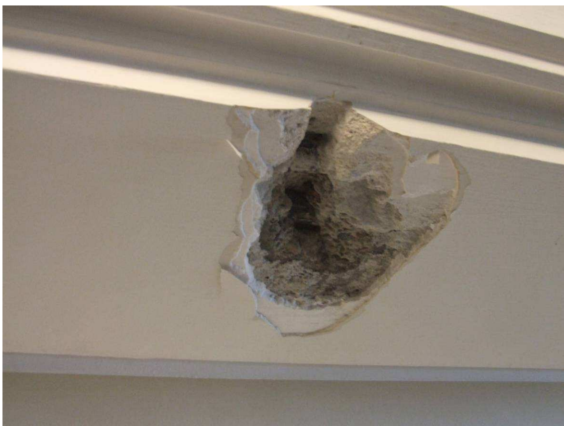
Fot. 19 - odkrywka zbrojenia żebra stropu S1
