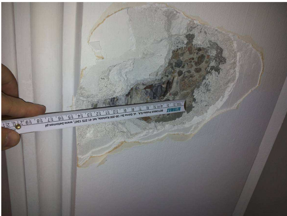
Fot. 18 - odkrywka zbrojenia żebra stropu S1
