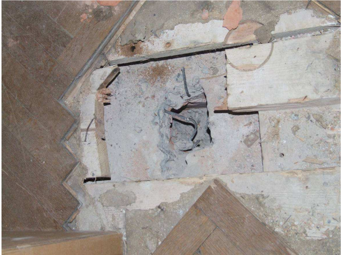
Fot. 38 - odkrywka warstw podłogowych oraz stropu S6 (gęstożebrowego Ackermana). Otwór w pustaku z widokiem zbrojenia.
