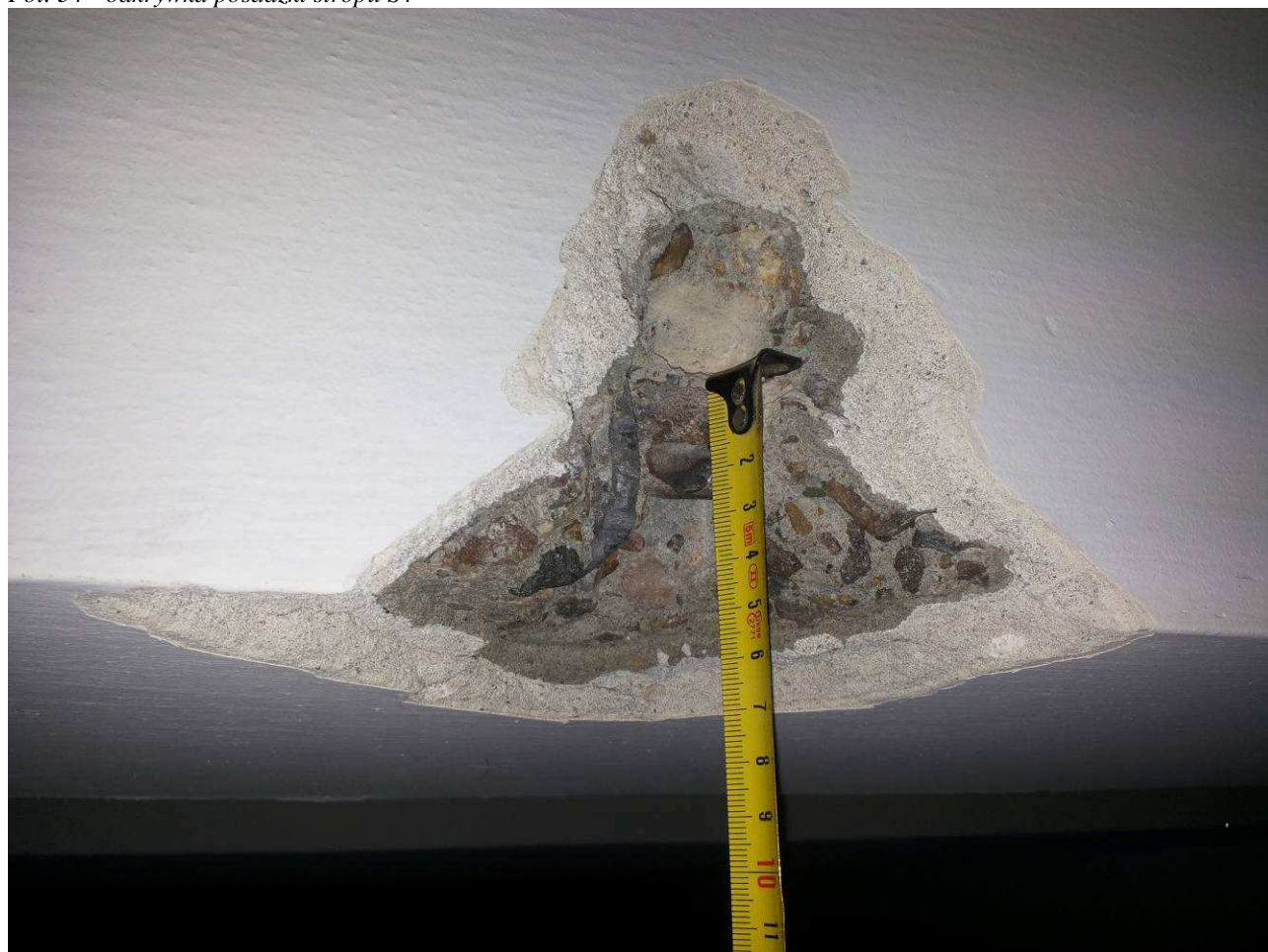
Fot. 35 - zbrojenia belki - widoczny pręt Ø28 i strzemię Ø6
