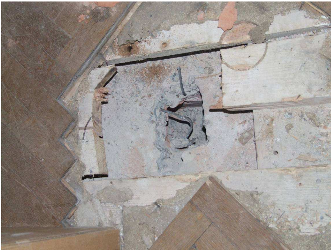
fot.11. Widok odkrywki konstrukcji stropu - widoczna pustak w miejscu kanału pustaka Ackermana oraz zbrojenie (strzemię)
