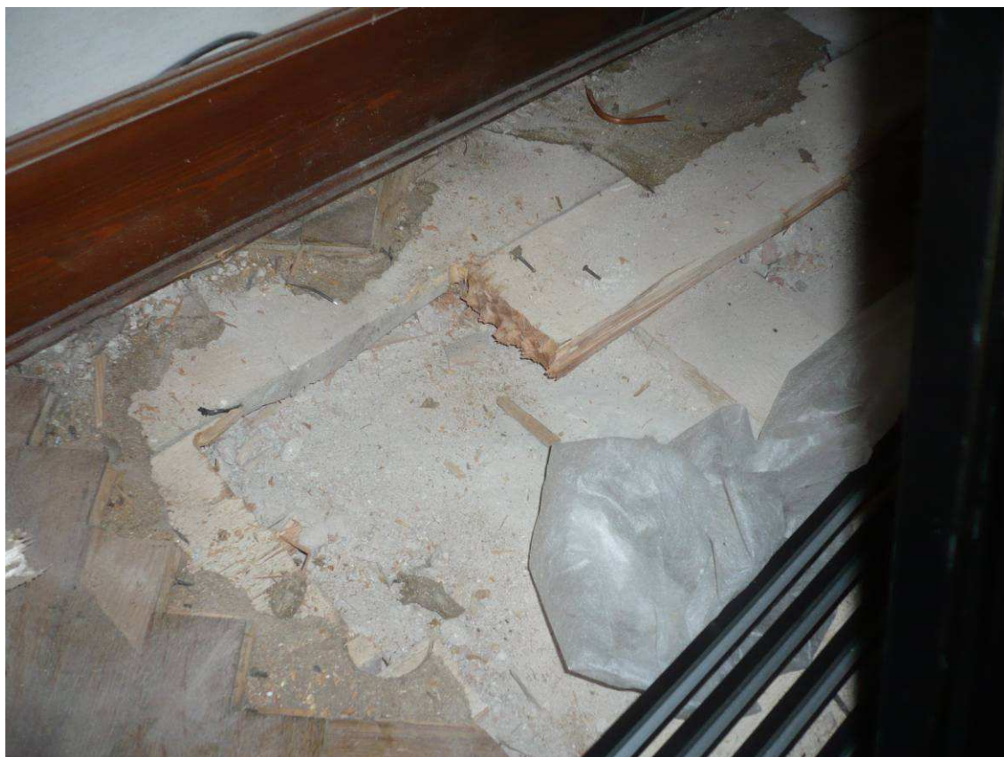
Fot. 34 - odkrywka posadzki stropu S4
